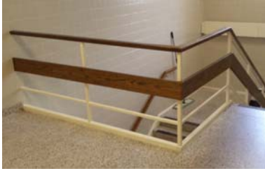
Non Compliant stairs
