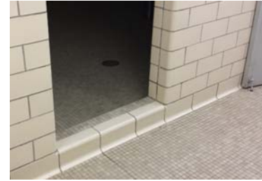
Non compliant showers
