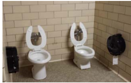
Non compliant toilets
