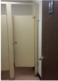
Non compliant toilet
